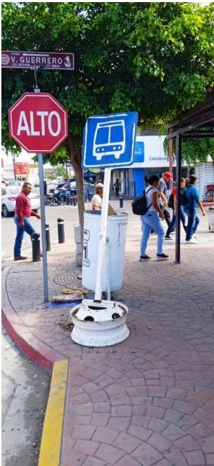
24 / 07 / 23 se retiro estructura metalica de parada de camiones se dio de baja en malas condiciones
