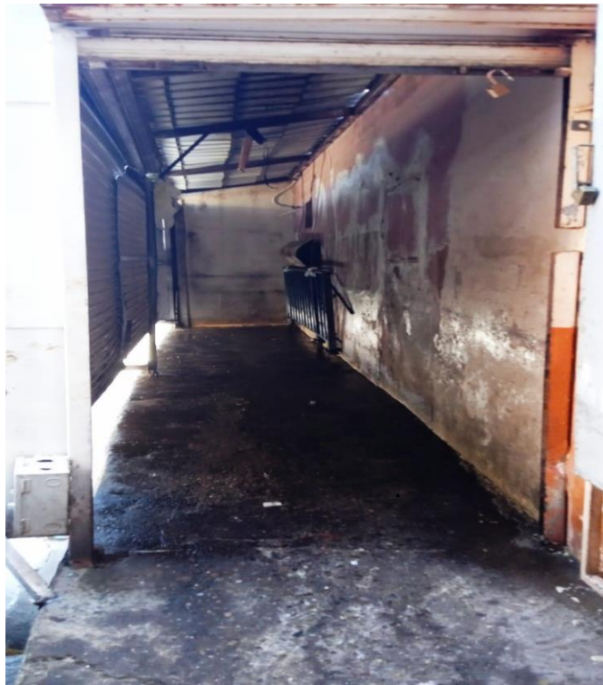
08 / 07 / 23 contenedor de basura area interior limpieza y lavado
